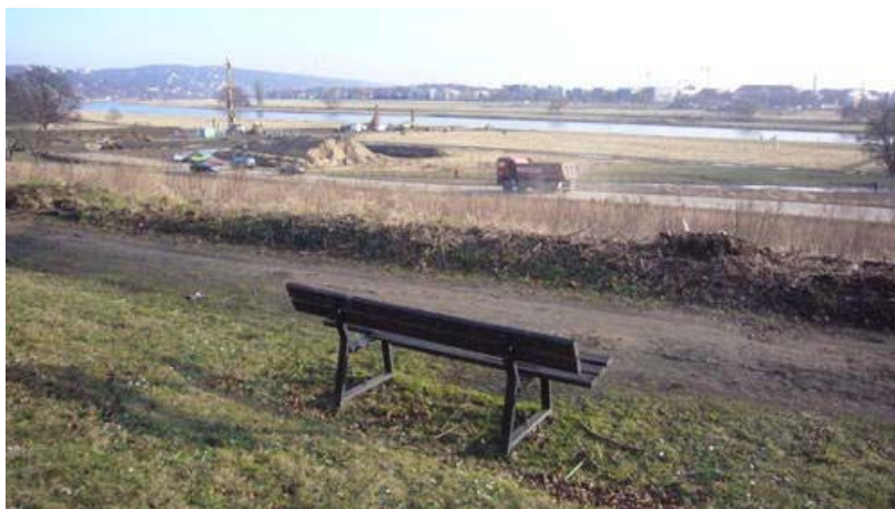
Début de la construction du pont en 2008. © Giovanni Boccardi/Centre du patrimoine mondial
