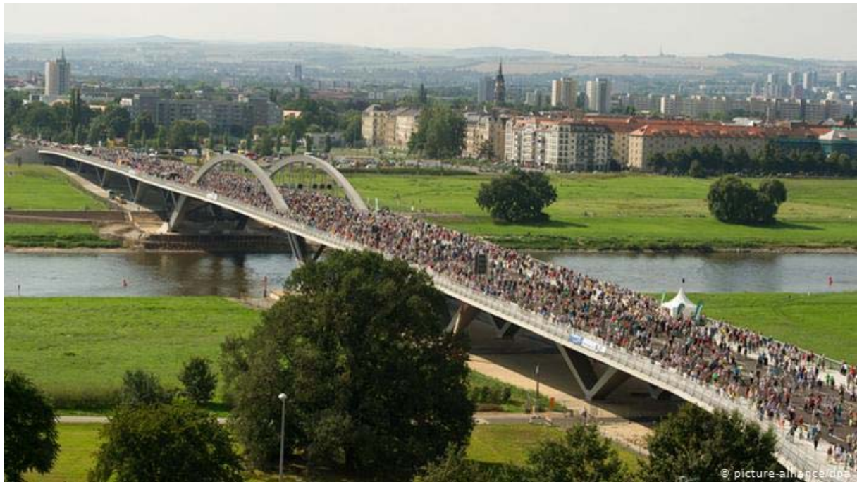
Inauguration du pont en août 2013.
